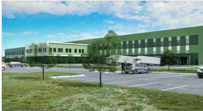
Vue du futur entrepôt de CSP à Cournon-d'Auvergne.
